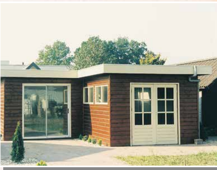
▲ Aanbouw afm. 500x320cm uitgevoerd in dubbelwandig houtskeletbouw (gepotdekselde buitenkant), plat mastiek dak, loopdeur, 3 ramen en betonvloer.
