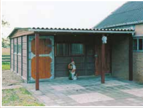
◀ Aanbouw berging/paardenstal, bruin houtmotief, zadeldak met zwarte golfplaten, overkapping 150 cm.
