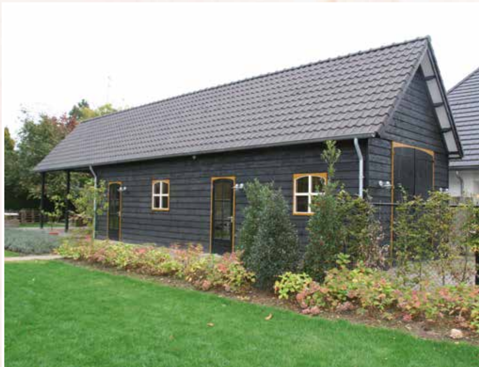
Garage/veranda afm. 1800x450x300 cm, veranda ondersteund met bankiraypalen, garage dubbelwandig houtskelet met potdekseldelen, zadeldak 45° met gebakken pannen, zinken goten, getoogde draaideuren, loopdeuren, ramen met roeden en betonvloer bewapend.
