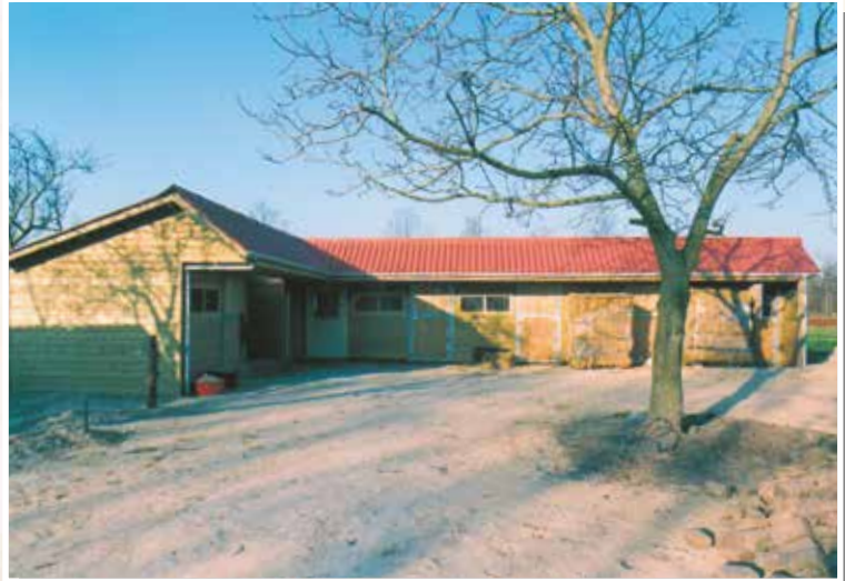
▲ Paardenstal in L-vorm, dubbelwandig rabat, zadeldak met rode golfplaten, 130 cm overstek.
