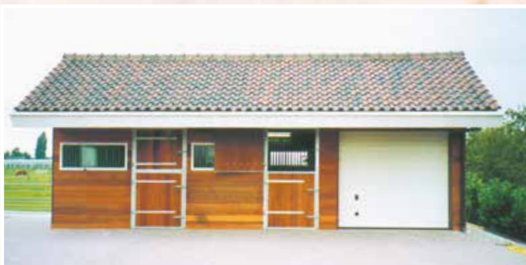
Garage/paardenstal, 930 x 630 x 250 cm, dubbelwandig rabat (Redceder), 30° zadeldak met geplazuurde pannen, 130 cm overstek, één sectionaaldeur. ▼
