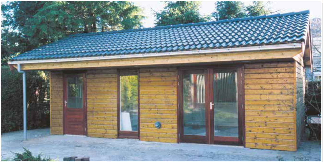
▲ Studio, 930 x 475 x 250 cm, dubbelwandig rabat, 30° zadeldak met pannen, 120 cm overstek, hardhouten deuren en kozijnen, geheel geïsoleerd.
