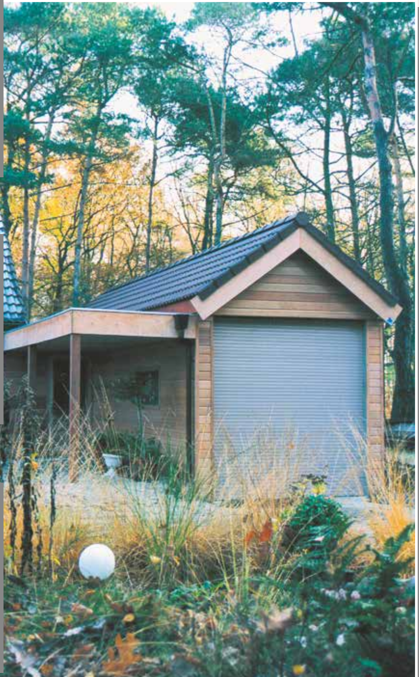
Aanbouw garage met afdak, 930 x 320 x 250 cm, dubbelwandig meranti rabat, 35° dak met pannen, roldeur, geheel geïsoleerd. ▼
