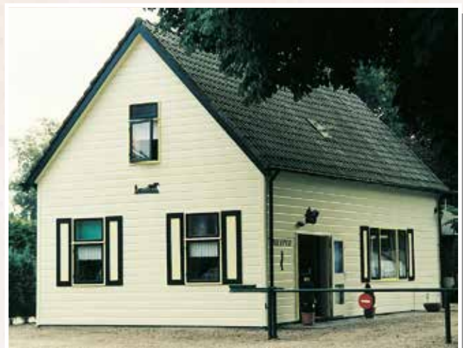
Kantoorruimte, 930 x 630 x 285 cm, dubbelwandig rabat, 45° dak met pannen, geheel geïsoleerd. ▼
