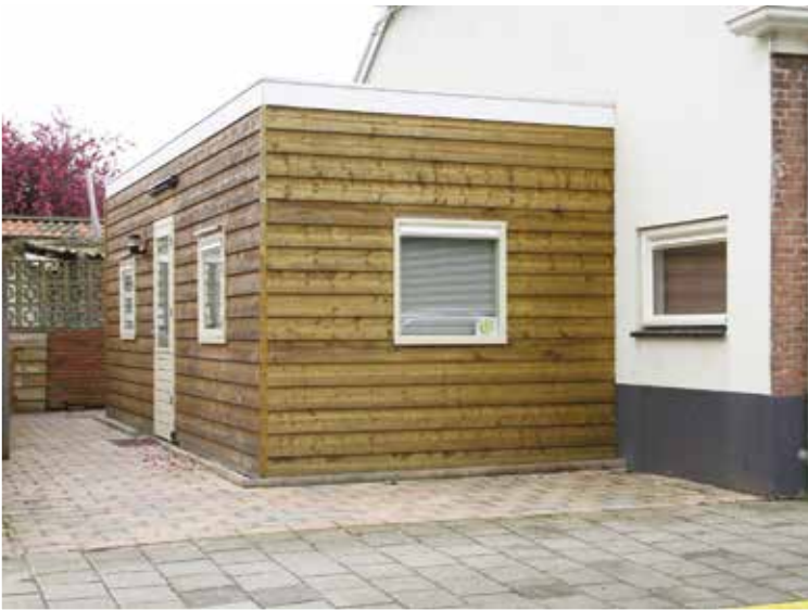
▲ Aanbouw afm. 500x320cm uitgevoerd in dubbelwandig houtskeletbouw (gepotdekselde buitenkant), plat mastiek dak, loopdeur, 3 ramen en betonvloer.
