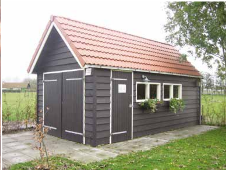
◀ Garage 630x320cm, dubbelwandig houtskelet (potdekseldelen), zadeldak met sneldek dakpannen, dubbele draaideuren, loopdeur, ramen en betonvloer.
