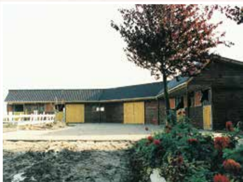
Garage/paardenstal, 930 x 630 x 250 cm, dubbelwandig rabat (Redceder), 30° zadeldak met geplazuurde pannen, 130 cm overstek, één sectionaaldeur. ▼
