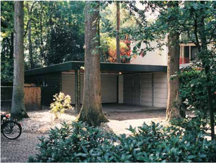
▲ Aangebouwde garage/carport, 1545 x 630 x 250 cm, dubbelwandig rabat, plat mastiek dak, geheel geïsoleerd.
