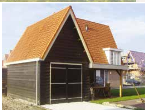
◀ Garage/berging met overkapping, dubbelwandig houtskelet (potdekseldelen), stijl zadeldak met sneldek dakpannen, 1 stel dubbele draaideurem, 1 loopdeur met glas, 1 raam overkapping met plat dak uitgevoerd.
