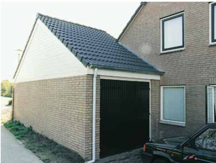
▲ Aanbouw garage, 630 x 320 x 215 cm, binnenwanden houtskelet, buitenwanden gemetseld, 40° dak met pannen, geheel geïsoleerd.
