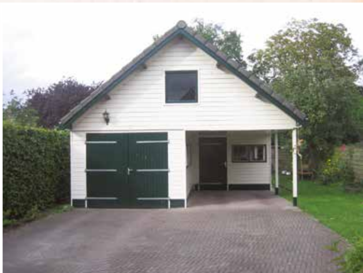
◀ Garage afm.630x630cm met terugval, dubbelwandig rabat, dakpannen, dubbele deuren, loopdeur, raam in topgevel en betonvloer.
