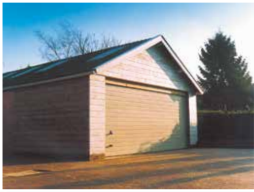
◀ Robuuste garage 1240 x 630 x 250 cm, dubbelwandig rabat, 30° dak met golfplaten, sectionaaldeur, evt. met afstandbediening.
