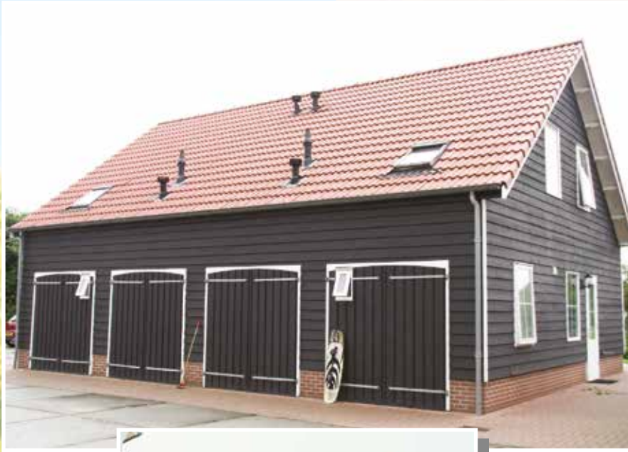
◀ Garage 930 x 780 x 250 cm, dubbelwandig rabat, 45° dak met pannen, met aanbouw geheel geïsoleerd.
