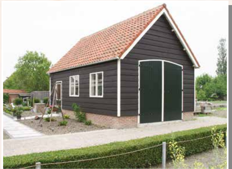
► Fraaie garage afm.730x320cm, dubbelwandig houtskeletbouw op gemetseld trasraam, dakpannen, dubbele deuren en betonvloer.
