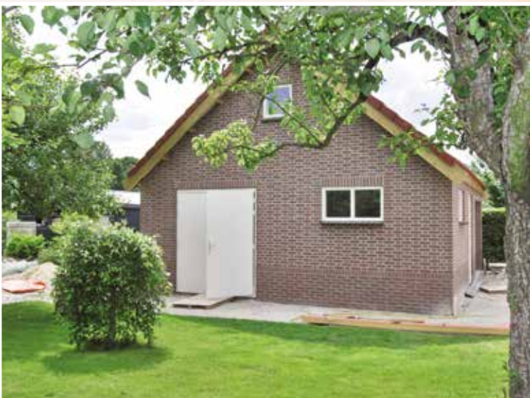
▲ Aanbouw garage, 630 x 320 x 215 cm, binnenwanden houtskelet, buitenwanden gemetseld, 40° dak met pannen, geheel geïsoleerd.
