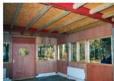
Begaanbare zolder met stalen spanten
