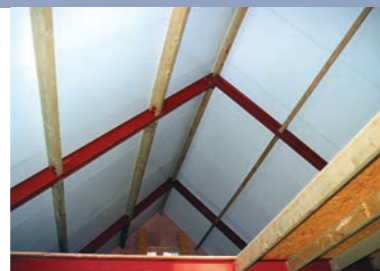
Begaanbare zolder met stalen spanten
